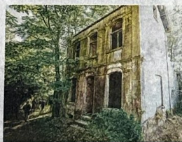
De vervallen tuinierswoning wordt een vakantiewoning.
